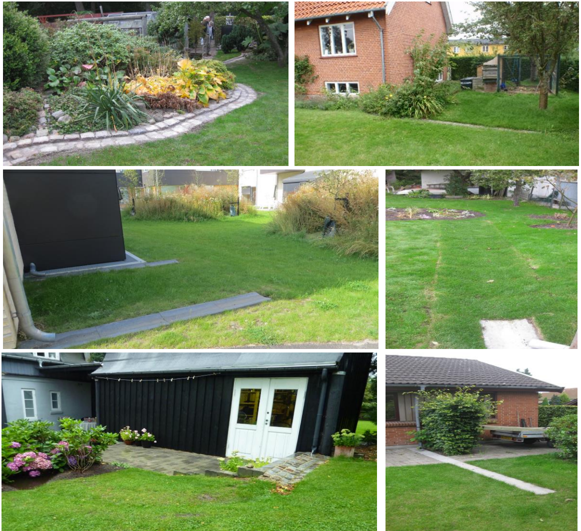
Figur 4.2. Forskellige eksempler på udformning af render, der leder vandet væk fra huset
